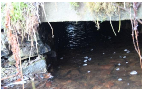
Abbildung 47: Bauwerk des ersten Durchlass
