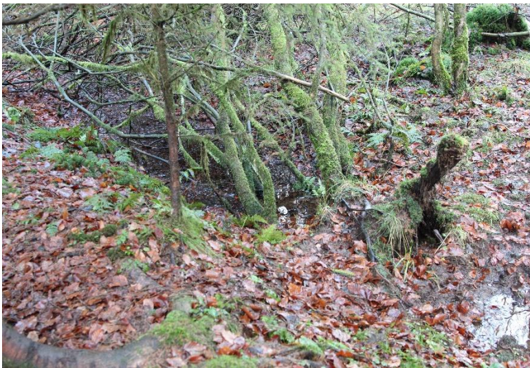
Abbildung 42: Stauwirkung im zweiten Drainagegraben durch im Graben wachsendes Gehölz
