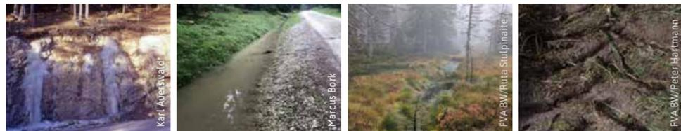
An Hangböschungen entlang von Forstwegen wird der Zwischenabfluss angeschnitten, welcher dann wieder zutage tritt und in den Wegeseitengräben talwärts fließt.
