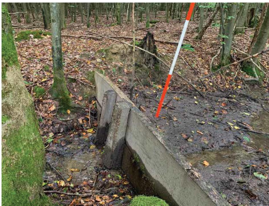
**Abb. 3:** Wasserrückhalt ist Humusschutz. Diese Sohlschwelle in einem ehemaligen Entwässerungsgraben (Nister) hat nach nur anderthalb Jahren neben Wasser auch mehr als einen halben Meter Humus zurückgehalten und uns die Augen geöffnet. In der EU gehen jährlich 1 Milliarde Tonnen Boden durch Wasser- und Winderosion verloren. 1 Gramm Humus speichert 10 Gramm Wasser (Bodenatlas 2024). (Foto: Monika Runkel)
